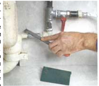
1. Зачистка участка трубы водопроводного стояка с помощью напильника
