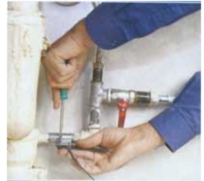
3. Крепление конца медного провода к трубе с помощью специального металлического хомута
