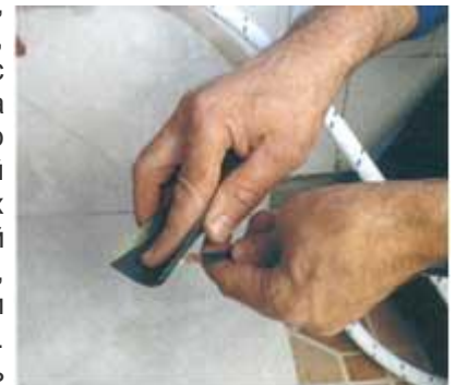
2. Зачистка концов медного провода
