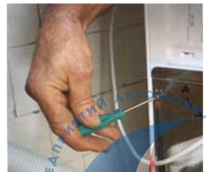
6. Крепление другого конца медного провода к металлическому корпусу стиральной машины.
