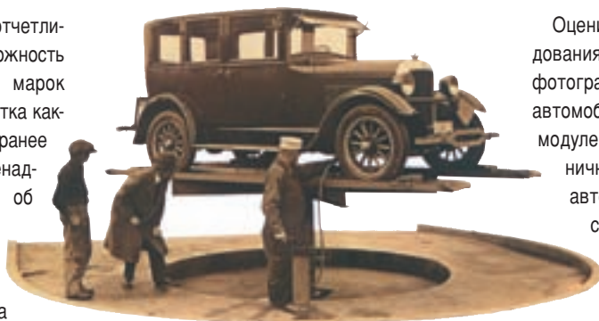
Рис. 1. Первый гидравлический подъемник существенно облегчил работу автосервисных мастеров.
